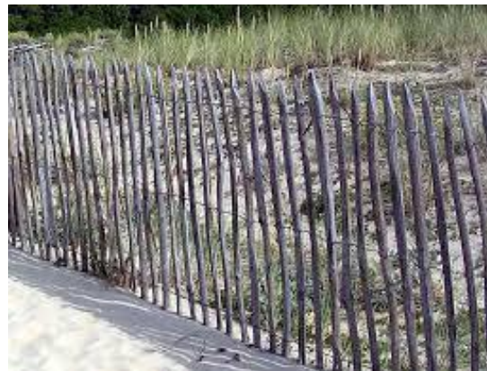
Ganivelle pour stabiliser la plage, encadrer
