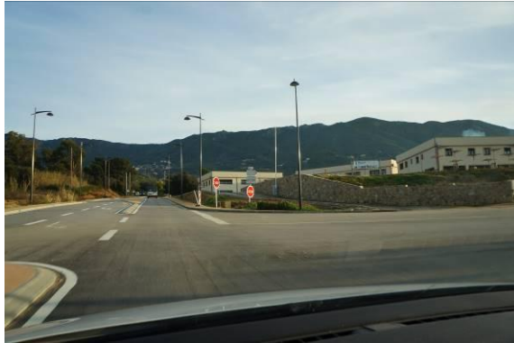
RD81 – Carrefour aménagé de Stagnone
