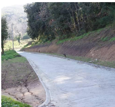
Route communale en travaux
