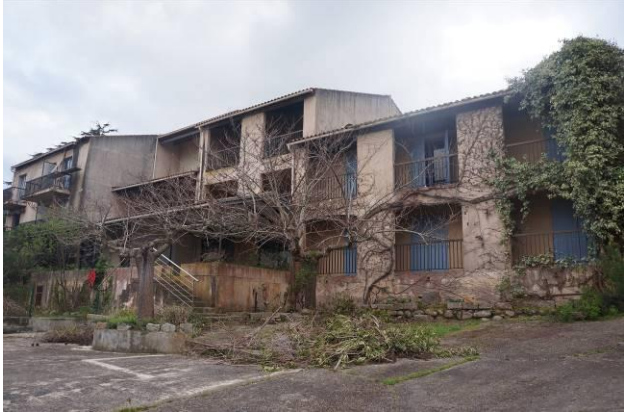
Logements vacants en état d'abandon – Orcino
