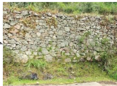
Exemple de murs de soutènement
