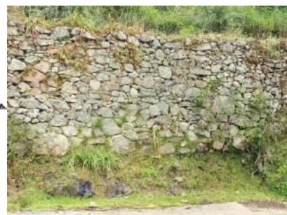
Exemple de murs de soutènement
